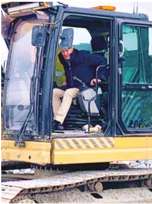
FMIN gravde selv ned grunnstenen med en 25 tonn gravemaskin.
