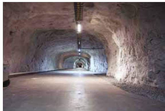
Flere km med tunneller i fjellet.
