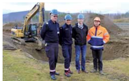
Fornøyd med oppstart for ny brannstasjon på Bardufoss. Fra venstre: Ivar Granheim og Stig Mikkelsen fra brann- rednings- og plasstjenesten, prosjektleder Tor Arne Fagerheim fra Forsvarsbygg og anleggsleder Jan-Einar Nilsen fra TP Maskin AS. Foto: Beate Ingebrigtsen, Forsvarsbygg.
