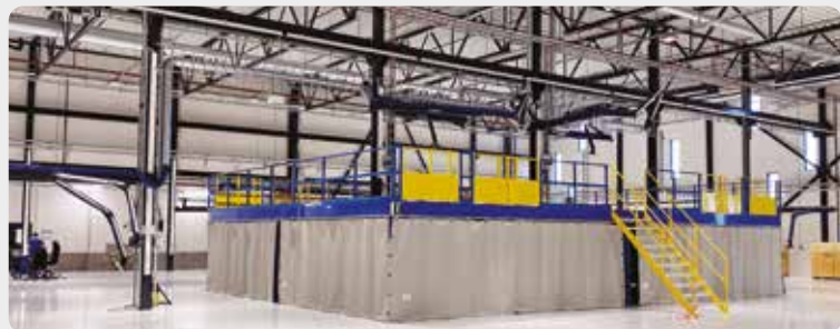
Fra innsiden av hallen.
