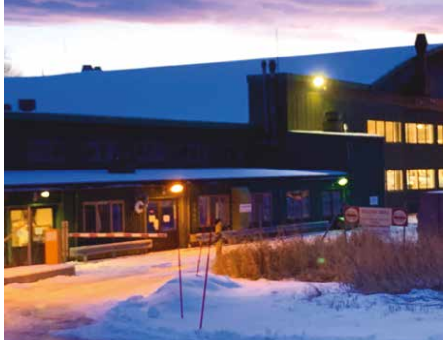
Kveldsstemning ved vedlikeholds-hangaren.
