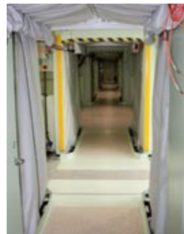
Trange, men lufttette korridorer mellom containerne.
