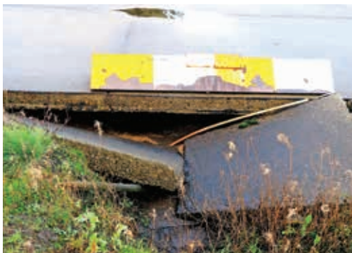
Asfalt og betong-dekket på flyparkeringsområdene raser snart sammen.
